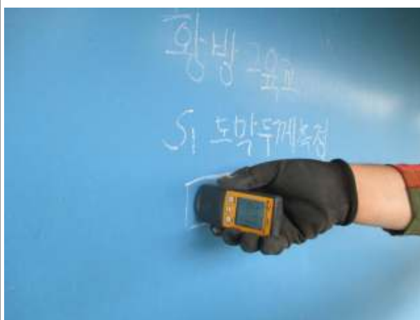
거더 외부 도막두께 측정
