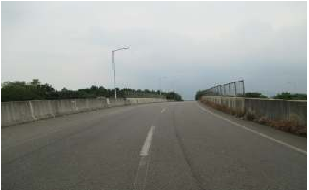
교량 상면 전경
