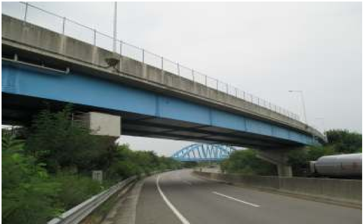
교량 측면 전경
