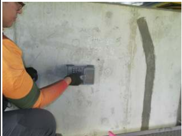
철근 피복두께 측정
